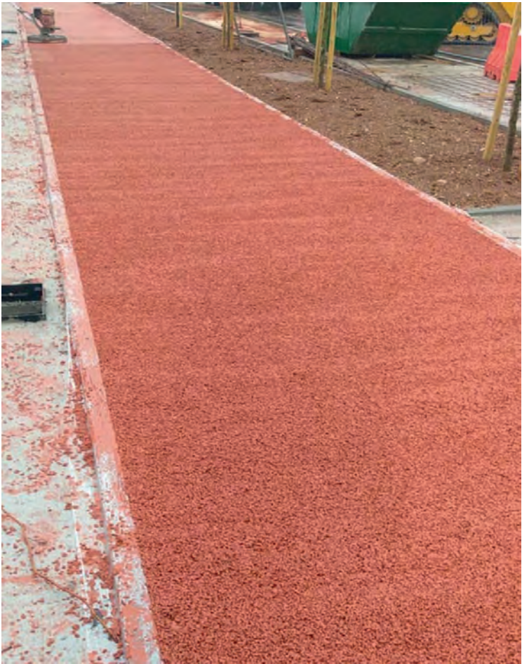
Esempio marciapiede in drainbeton (Typ.)
